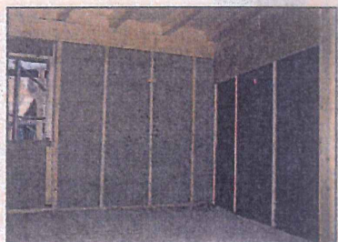
So sehen Innenwände mit Holzleichte-lehm aus. (Bild Gorajek)
