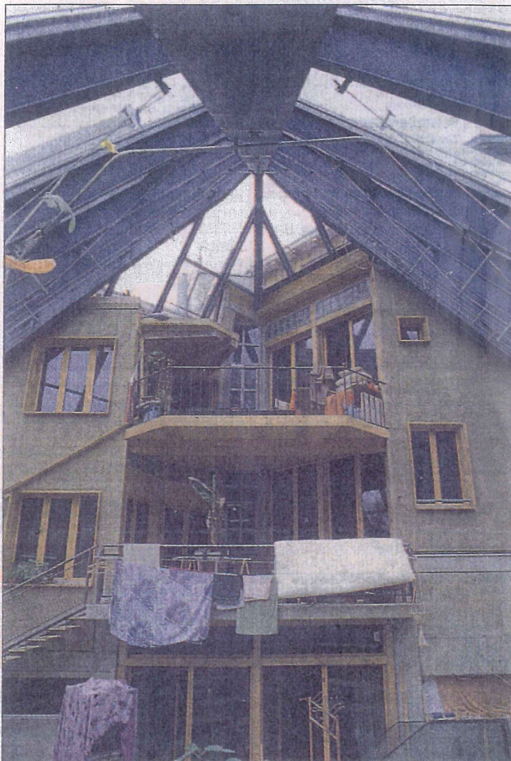
Energetische Architektur im Ökohaus Felsenau: Der Wintergarten heizt die Lehm-speicherwände auf. (Bild Bucher)
